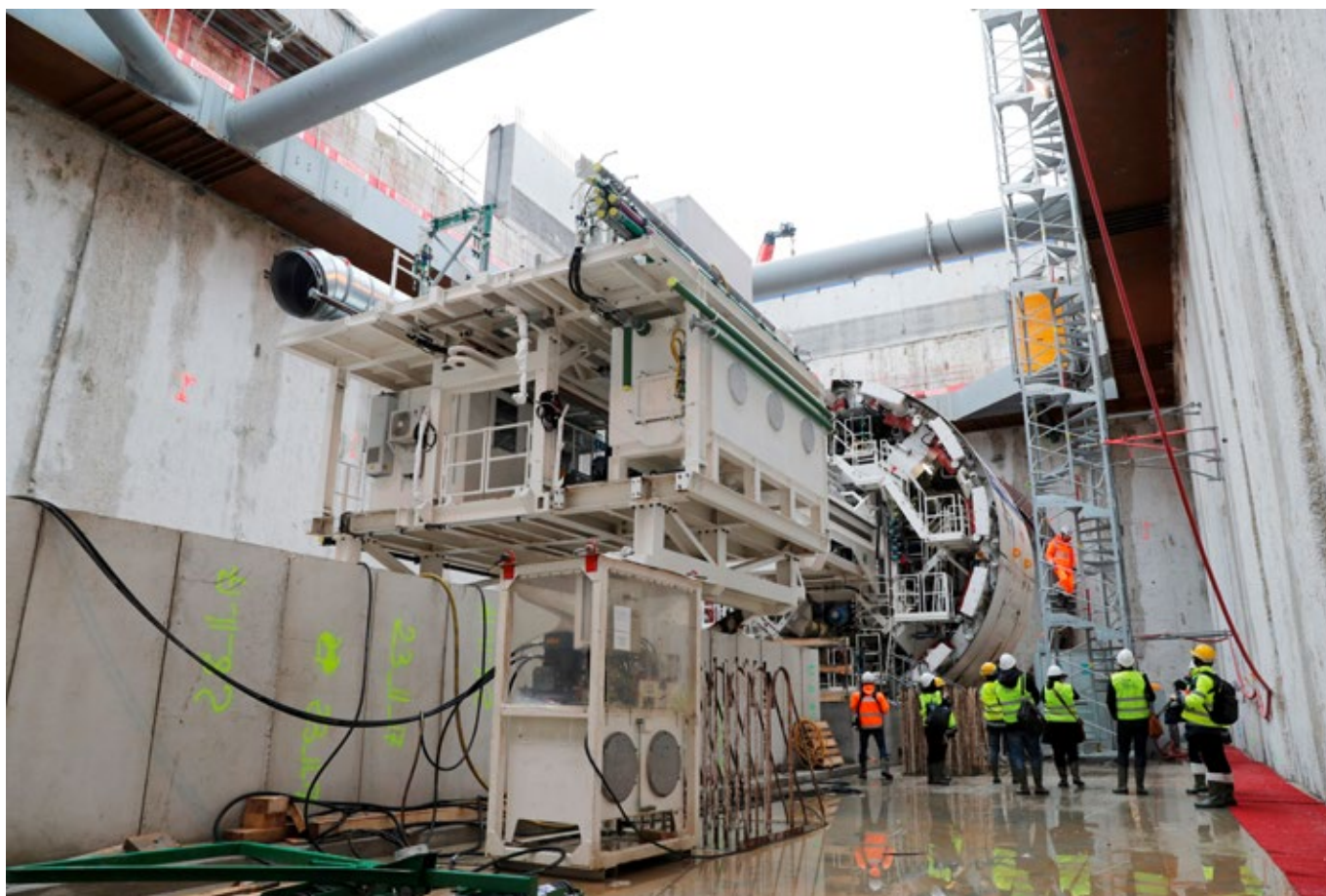
Im Zuge des Grossprojekts «Grand Paris Express» wird derzeit das Pariser U-Bahn-Netz erweitert.
